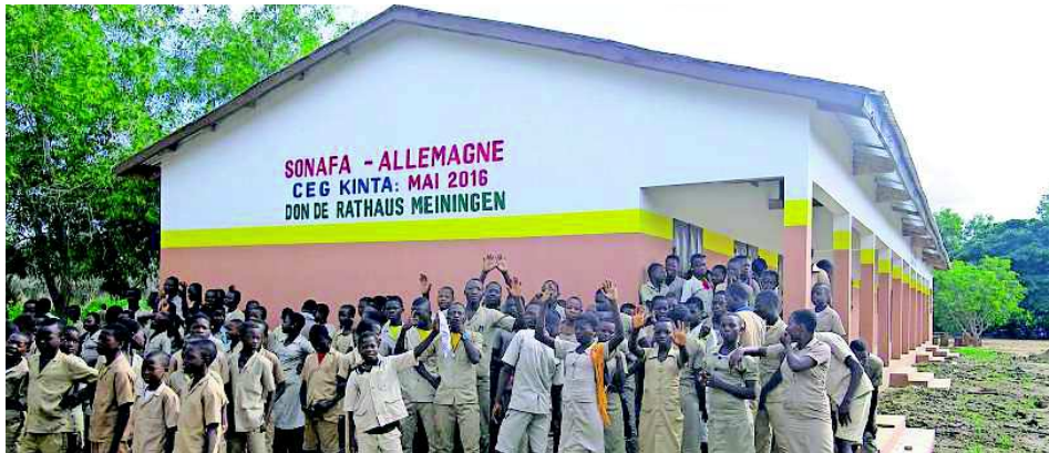
Mit einer kleinen Spende der Stadt Meiningen und der Rhön-Rennsteig-Sparkasse wurde die Initiative zum Schulbau ausgelöst. An der Giebelwand des fertigen Schulhauses ist der Dank an das „Rathaus Meiningen“ formuliert. Den Hauptteil der Kosten übernahm aber der Verein Sonafa.
